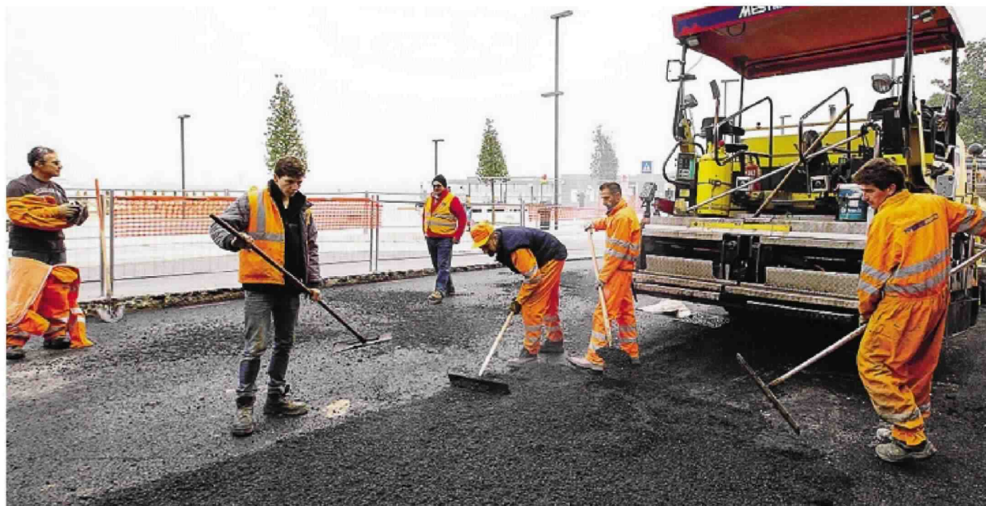
Continua la fase di sperimentazione per l'asfalto speciale con l'additivo al grafene di I terchimica che raddoppia la sua vita media
