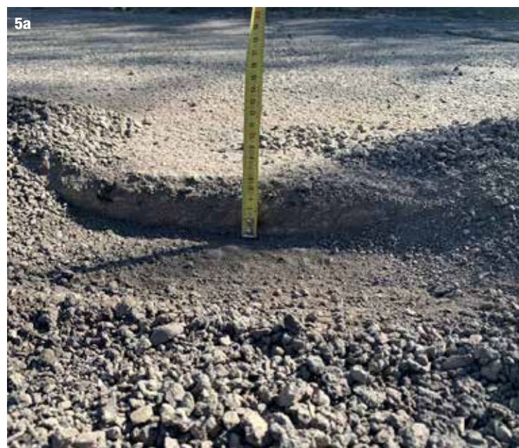
Fig. 5: Materiale fresato risultato dal passaggio della fresatura.
