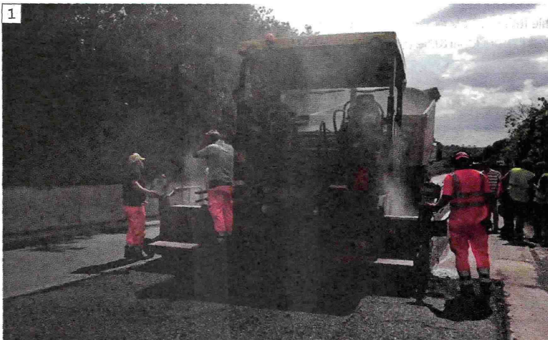
1 Lavori di posa del manto stradale al grafene per il test condotto sulla via Ardeatina, nei pressi di Roma
