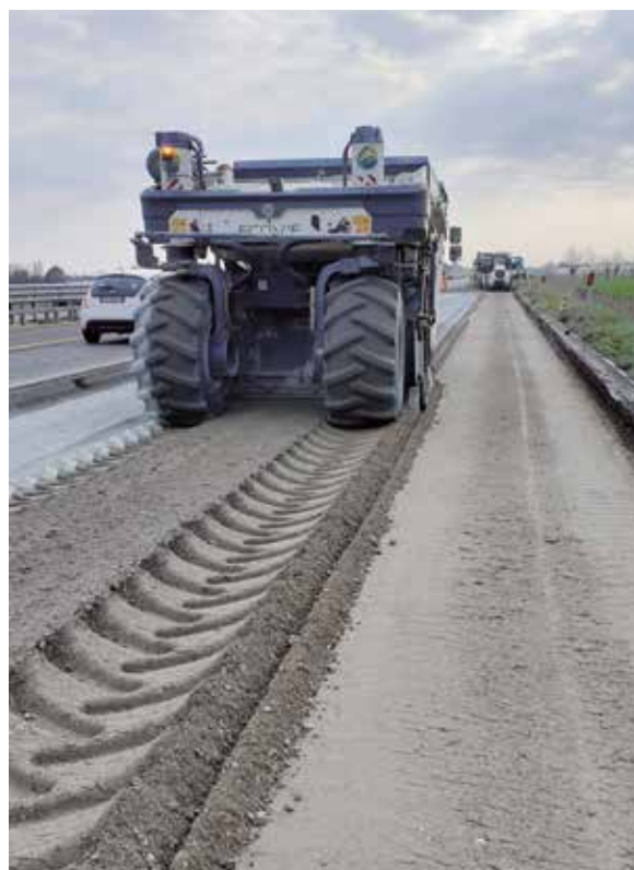
Fig. 6 - Lavori in notturna.
