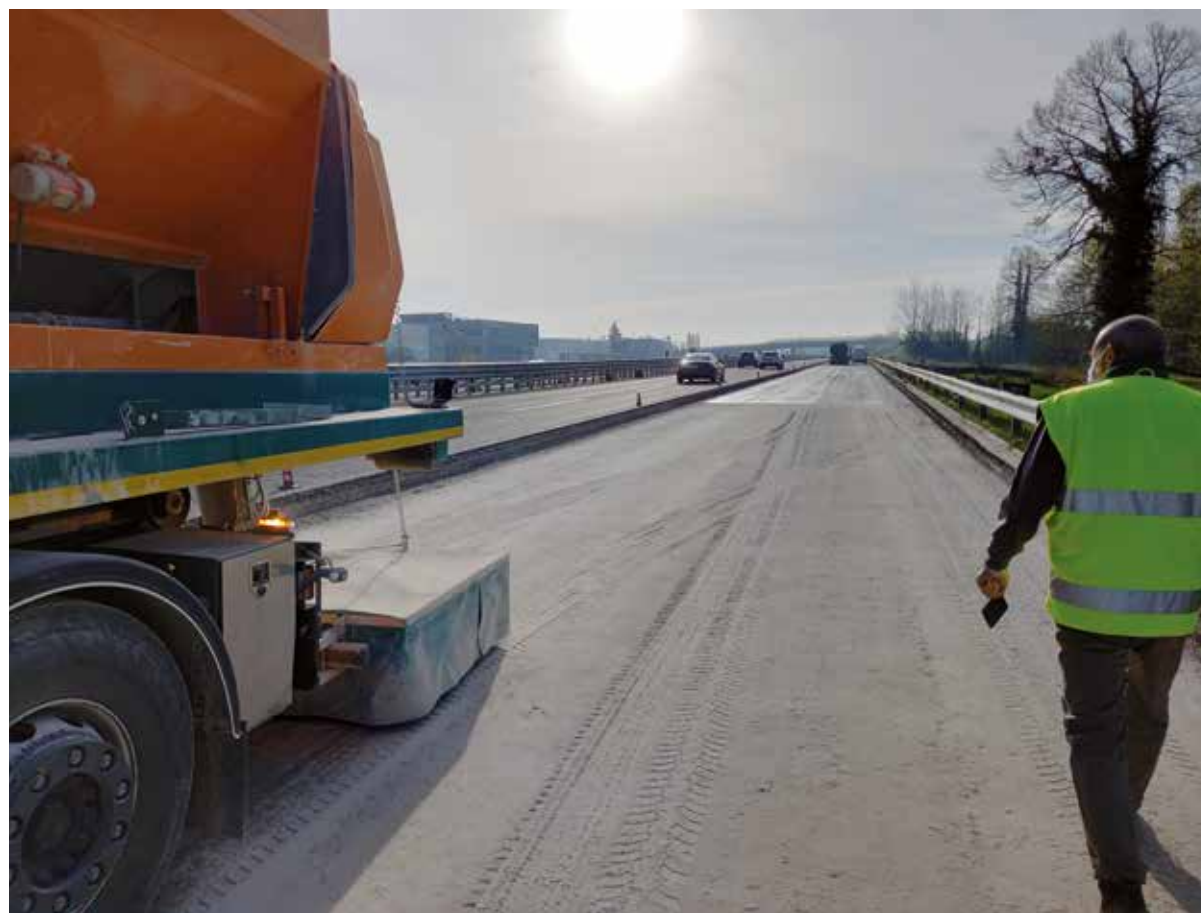
Fig. 9 - Lavori di preparazione del piano di posa degli strati di rinforzo.
