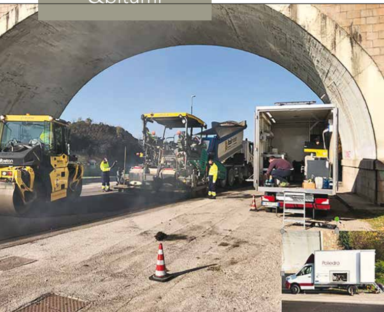
5. La fase dei controlli in corso d'opera con laboratorio mobile
