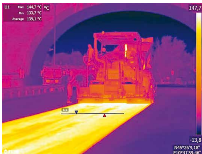
6. L'immagine termica del conglomerato in fase di stesa
