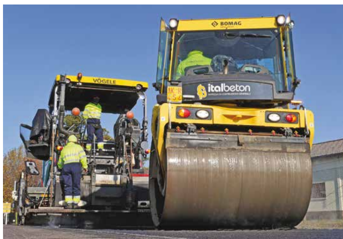
2. Macchine asfaltatrici all'opera a Peschiera del Garda (VR)
